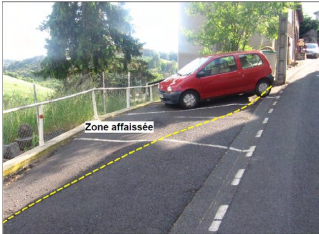
Figure 10 : affaissement d'un parking dans la rue du Thuilé bas (Photo BRGM)
