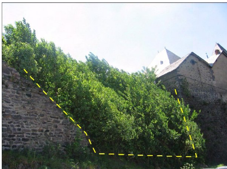
Figure 7 : effondrement d'une section d'un mur de soutènement du parking du Canon, rue du Muret (photo BRGM)
