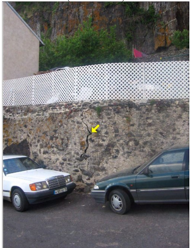
Figure 13 : mur de soutènement fissuré/bombé, rue des Planchettes (Photo BRGM)
