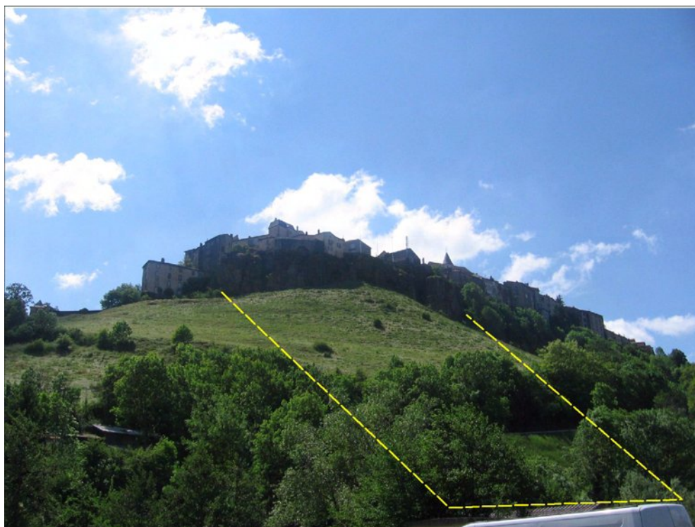
Figure 23 : secteur sous la ville haute traversé par la rue des verdures, menacé à la fois par des chutes de pierres/blocs et des glissements potentiels - alea fort (Photo BRGM)
