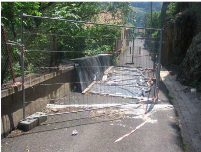
Figure 10 : affaissement d'un parking dans la rue du Thuilé bas (Photo BRGM)
