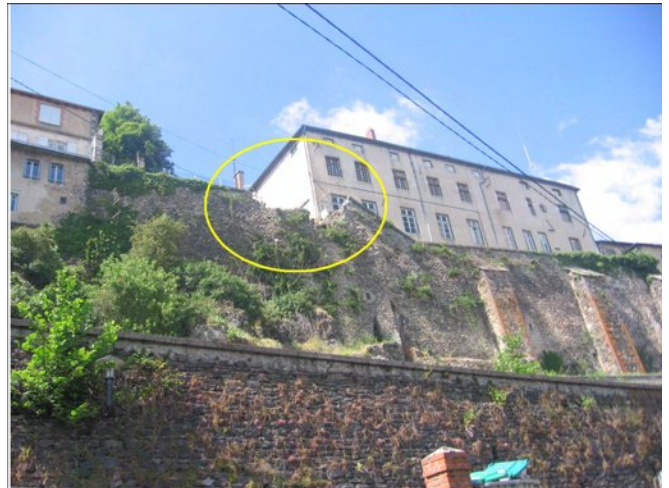
Figure 11 : désordre sur le rempart faisant soutènement au niveau de la rue de la Frauze (Photo BRGM)
