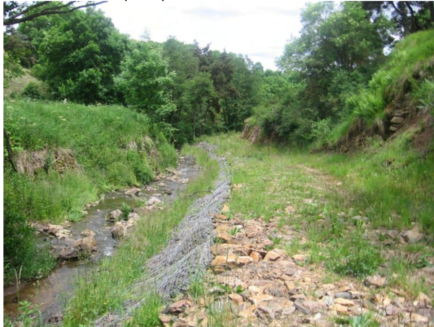
Figure 16 : Ruisseau de Fraissine – protection d'un chemin contre l'érosion (photo BRGM)
